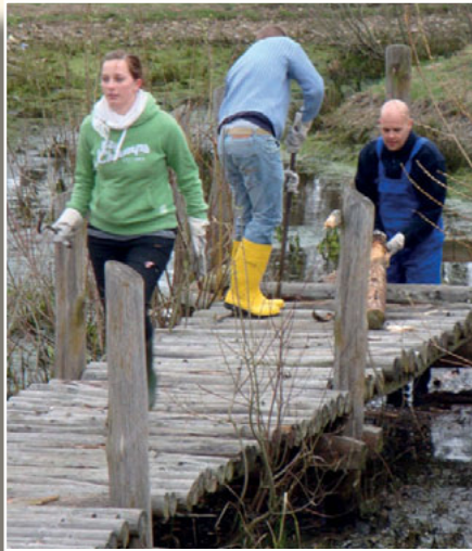
Zunächst muss der alte Steg mühevoll abgebaut werden.
